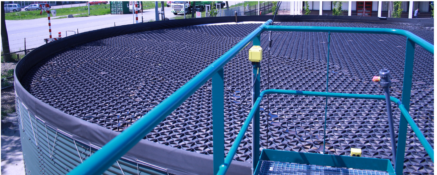
Hexa-Cover er udviklet til at afdække fx spildevandsreservoir. Produktet består af mange elementer, der flyder på væsken og dækker af for blandt andet lugtgener og fordampning.
